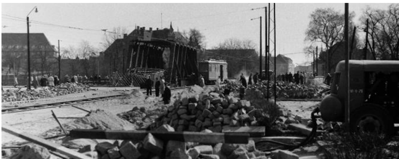
Hucisko, widok na przebudowywany wiadukt – przejazd tramwajowy – nad torami kolejowymi; w tle budynek ówczesnego Klubu Studentów Wybrzeża Żak (Nowy Ratusz) | fot. Krzysztof Kamiński (patrz str. 19)
